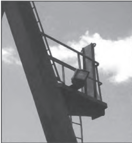
Escalera sin guardacaidas
