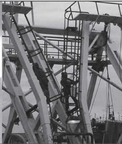
Escalera con guardacaidas
